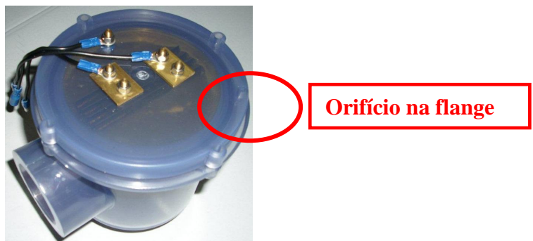
Figura 9 - Colocação dos novos eléctrodos no vaso de PVC.
