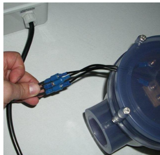
Figura 13 - Ligação entre a célula de sal e o quadro eléctrico Hidrion SAL.
